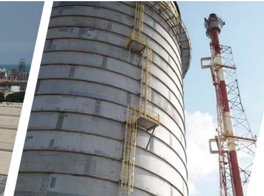
Enclosed Ground Flare tidak melepaskan buangan ke udara, mengurangi kebisingan, menghilangkan panas & asap
